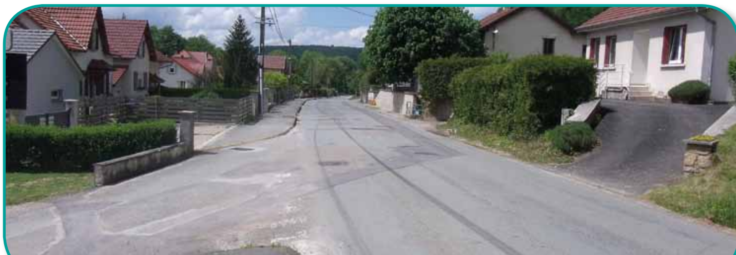
Réfection de la rue d'Helvétie
